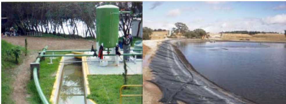
Oberflächenwasseraufbereitung (l), Klärteich (r)
